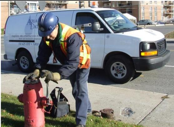
À l'aide d'un système de miroirs, Aqua Data vérifie le mécanisme de fonctionnement de la borne d'incendie, mesure la pression d'eau et détermine, s'il y a lieu, les priorités d'intervention. Tout cela vise la sécurité en cas d'incendie.
